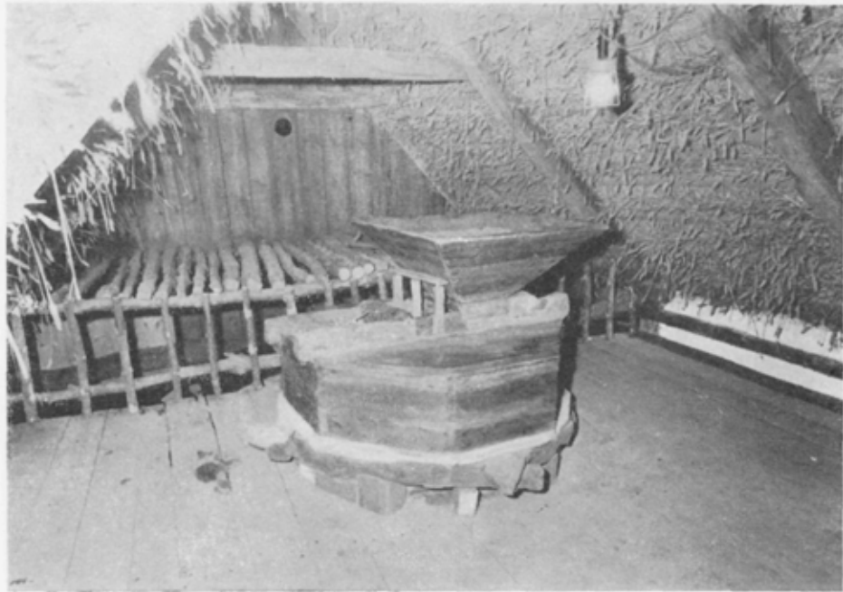
Fig. 3, neg. nr. 1167.14. Kværnloftet. Besætningen stammer fra DK-415-Lille Munkegaards Mølle, stenene fra DK-411-Vasagaardens Mølle. Slusegaardens Mølles inventar var næsten helt ødelagt. Bag tremmerne i baggrunden gaar vandhjulet.
