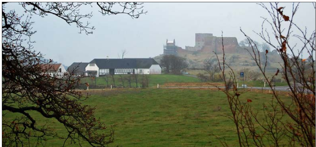
Det nuværende besøgscenter i Slotsgården skal nedrives, så sletten foran Hammershus fritlægges.
